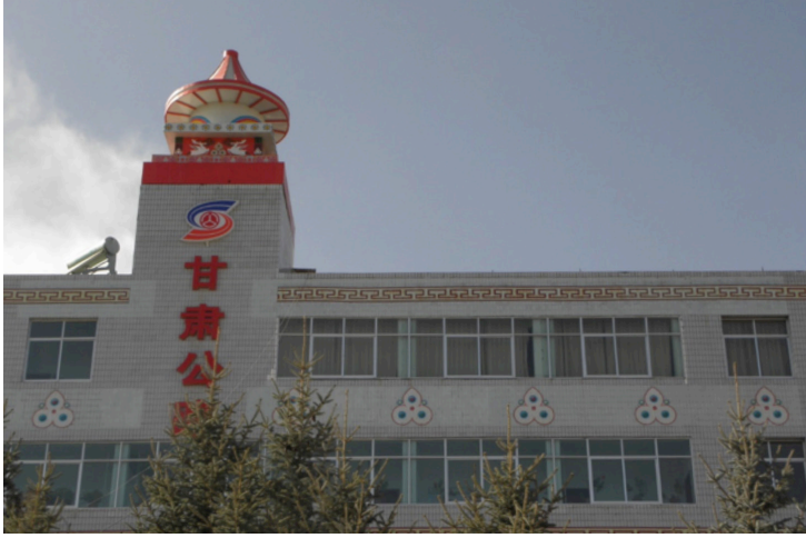
Resim-5 Sunan İlçesi Karayolları Dairesi'nin çatı kısmındaki Sarı Uyğur tarzı şapka mimarisi.
