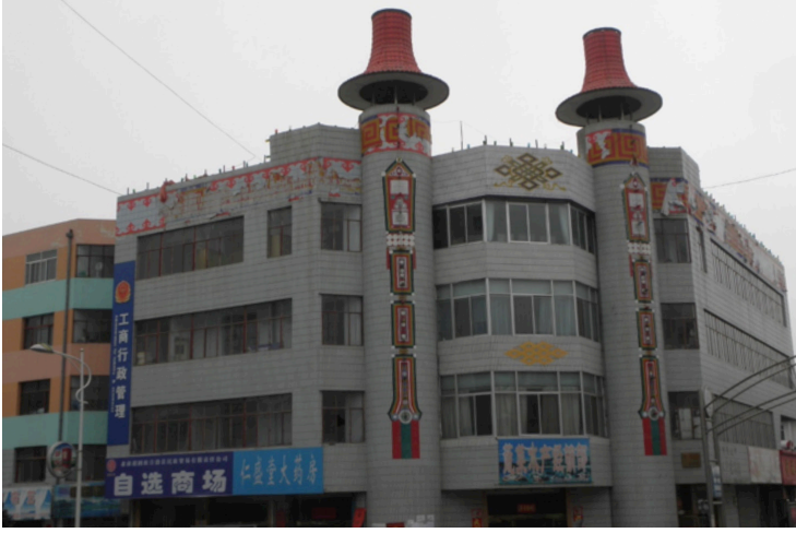
Resim-4 Sarı Uygurların yoğun olarak yaşadıkları Sunan ilçesinde bir iş yerinin önden görünüşü.
