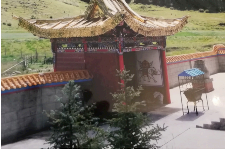
Resim-6 Sunan ilçesinin dış kısmında yer alan bir tapınağın giriş kapısı.
